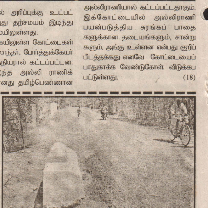
புளையம்பு செய்யப்பட்ட துருநகர் வீதியில் அமைக்கப்பட்ட மதகு ஒன்று உடைந்த நிலையில் காணப்படுகிறது. மிக அண்மையில் செப்பிடப்பட்ட மேற்படி வீதியிலுள்ள இம் மதகு ஆனது முன்னரும் ஒருதடவை உடைந்து மீள் அமைக்கப்பட்டதாகும். அத்துடன் மதகிற்கு ஊடாக நீர் வெளியேற முடியாத முறையிலும் அமைக்கப்பட்டுள்ளது. (படம்-சுகன்)
